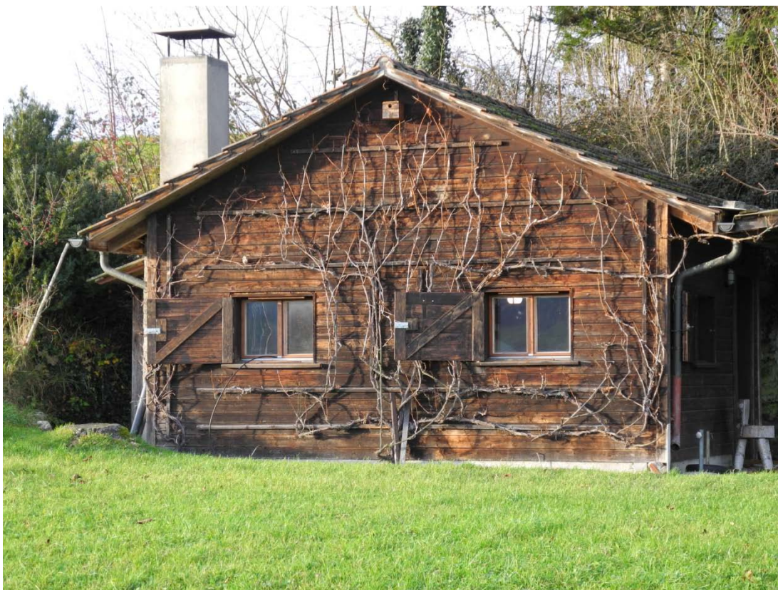
Die Heirihütte in Hünenberg
