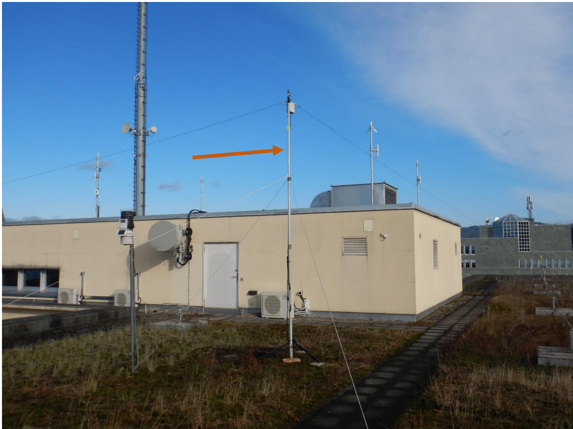
2: Mittelmast der KW-Antenne mit den beiden Schenkeln von je 20 m Länge
