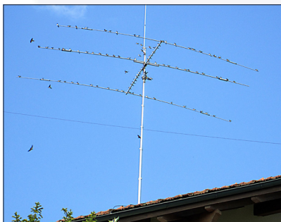
Eine drehbare Richtantenne; ein sog. Beam, die Querelemente sind ca. 8 m lang; hier offensichtlich gar für Vögel ein beliebter Aufenthaltort
