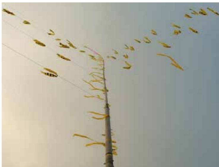
Nein, keine tibetischen Gebetsfahnen, sondern Warnwimpel, damit die Vögel auf Midway nicht in die Antennen und die Abspannungen fliegen.
