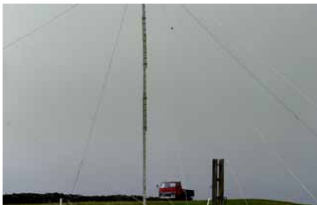
12m Leiter aufgerichtet als Hilfsmast; kl. LKW als "Zugmaschine"
