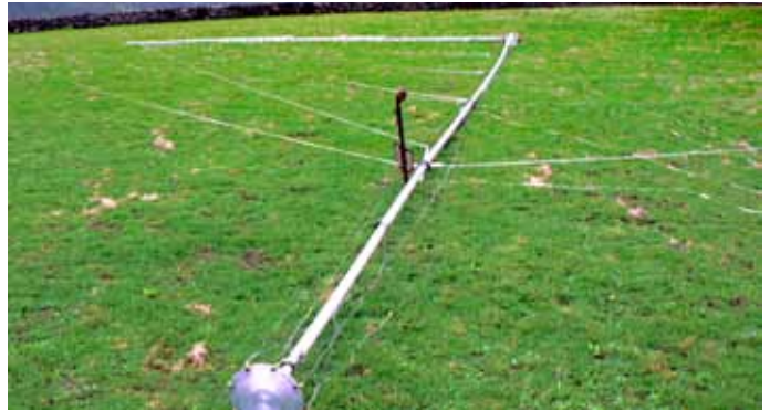
25m hohe GP bereit zur Aufrichte; rechtwinklig 12m Leiter als Hilfsmast
